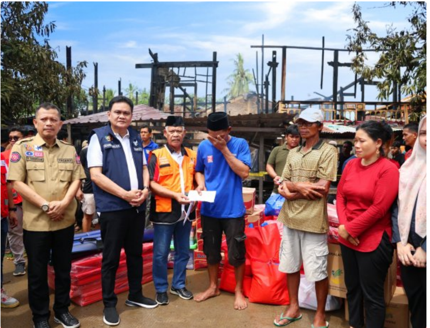
Bupati Barru, Ir. H. Suardi Saleh, M.Si, melakukan kunjungan ke lokasi kebakaran di Denpisu'e, Dusun Madello, Desa Madello, Kecamatan Balusu
